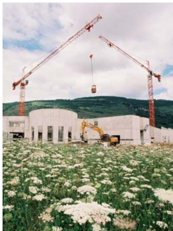
Construction du lycée de Foix-Ferrières en haute qualité environnementale (HQE)
